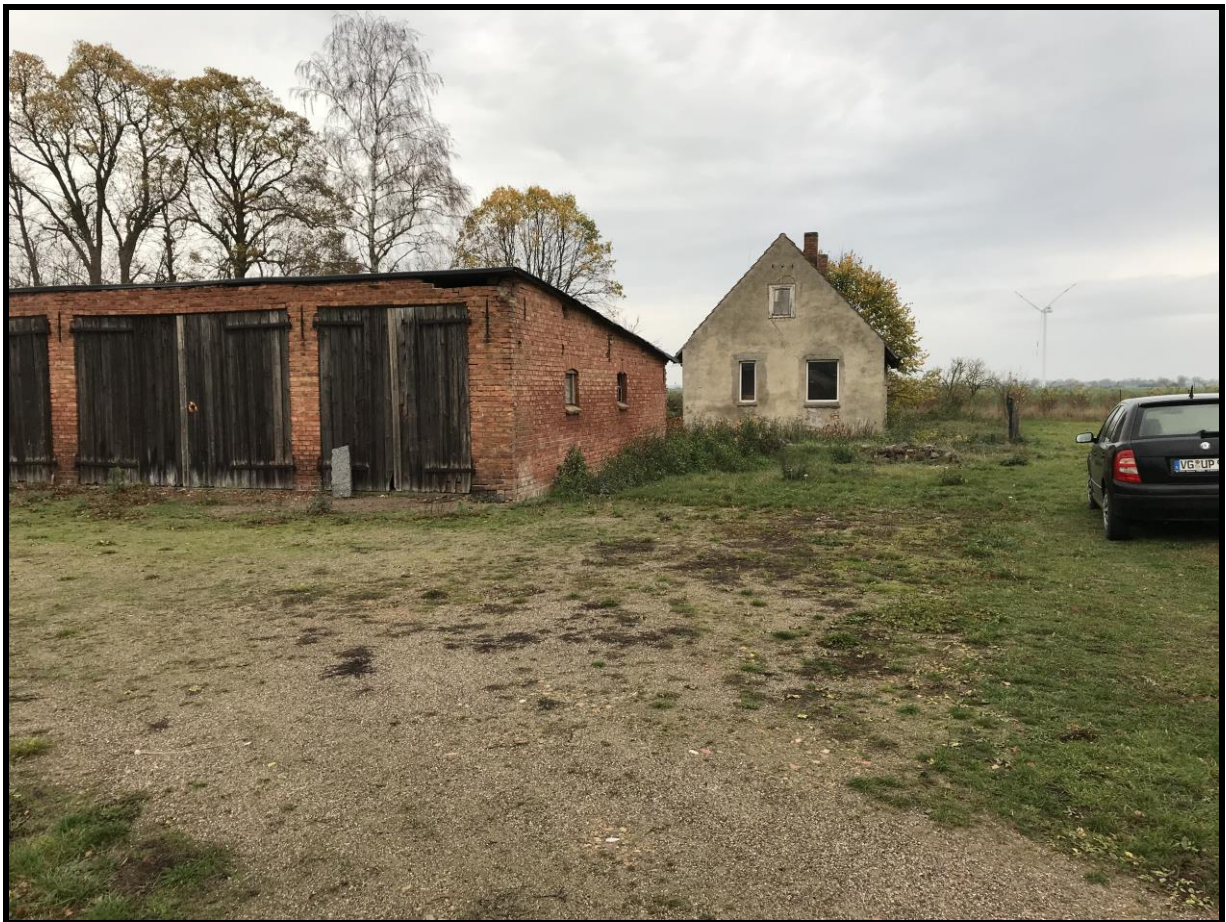
Abbildung 1: Foto des Vorhabenstandortes mit Blickwinkel nach Westen, Baukonzept Neubrandenburg GmbH vom November 2018
